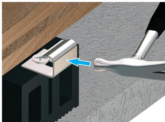
Монтаж финальных досок осуществляется стартовыми клипсами, предварительно просверлив отверстия сверлом 3 мм. Саморез вкручивается в лагу не до конца, так что бы клипсу можно было двигать. После укладки доски, клипса сдвигается в паз, вплотную к доске.
