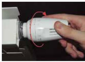
Полностью закрыть термостатическую головку поворотом ручки в положение «0».
