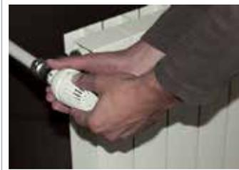
Вставьте термостатическую головку в шестигранное отверстие клапана и закрутите накидную гайку.
