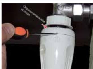
Установите ручку регулятора в положение, в котором ее надлежит зафиксировать, и отсоедините ограничительное кольцо при помощи отвертки.
