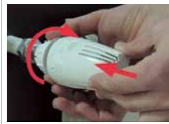
Завинтить гайку резьбового кольца с легким нажатием на термостатическую головку. Применяемое усилие вращения не должно превышать 18 Нм.
