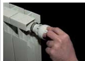
Закрывать термостатическую головку поворотом ручки до положения «\*»
