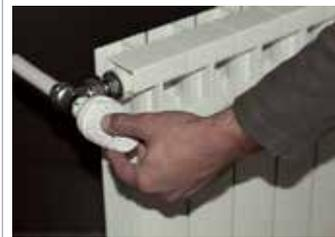
Теперь головка прикреплена к клапану, и с ее помощью можно задать желаемые температурные параметры.
