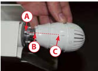
Для правильного выбора настроечного положения термостатической головки необходимо воспользоваться таблицей настроек, в которой указаны числовые значения на ручке, соответствующие определенным значениям комнатной температуры, определенные опытным путем в термостатической камере с использованием обогревательного прибора в оптимальном режиме функционирования.
