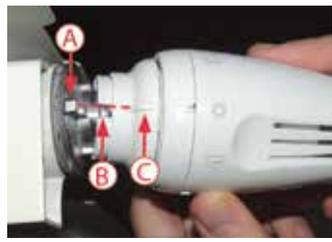
Присоединить термостатическую головку к клапану, проверить совмещение выступа клапана (A), монтажного паза термостатической головки (B) и контрольной насечки на кольце с зажимным соединением с защелкой (C).
