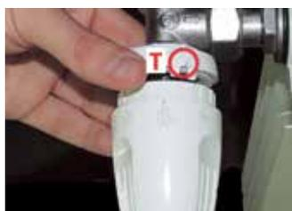
Поверните ограничительное кольцо. При помощи контрольной метки «Т» (см. рис.), которая служит ориентиром для правильного совмещения деталей, присоедините ограничительное кольцо, совмещая его с одной из трех пиктограмм, нанесенных на заднюю поверхность ручки:
