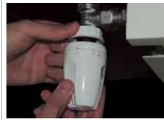
Вставьте термостатическую головку в шестигранное отверстие на корпусе клапана и закрепите ее поворотом гайки кольца по часовой стрелке.
