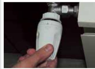
Теперь термостатическая головка прикреплена к клапану, и поворотом ручки-регулятора можно задать желаемые температурные параметры.
