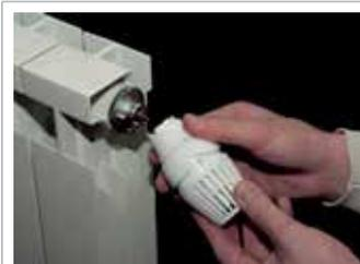
Полностью открыть термостатическую головку, посредством перевода ручки в установленное положение ☀.
