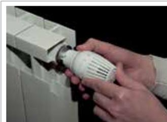
Подсоединить термостатическую головку к клапану, выступ на корпусе клапана (A) должен совпасть с пазом в лепестке цапги (B) и с указательной риской (C) термостатической головки. Выступ нельзя совмещать с прорезью между лепестками цапги.
