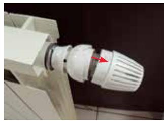
Установить ручку в требуемое положение и снять, потянув вперед.
