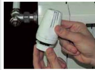
Полностью откройте термостатическую головку поворотом ручки в положение «☀».
