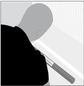
2. Облицовочная поверхность (стена или пол) должна быть тщательно выровнена, без отклонений (рекомендуется применение уровней и нивелиров). Сырые места следует предварительно герметизировать. Следует выровнять также слой клеевой смеси для избежания так называемых «бровок»
