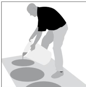
5. Тип клеевого состава выбирают в зависимости от того, какую поверхность надо облицевать (кирпичную, деревянную, гипсовую, металлическую...), свойств выбранной плитки (с или без добавления стекловолокна), формата плитки и ее предназначения.
