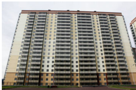
Ленинградская обл., Всеволожский район п. Девятино, ЖК «Мой город», номера домов с 3 по 9 Распределители тепла «Пульсар» - 5418 шт.
