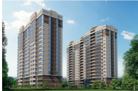
г. Краснодар, ЖК «Ежи» Квартирные теплосчетчики «Пульсар» 500 шт
