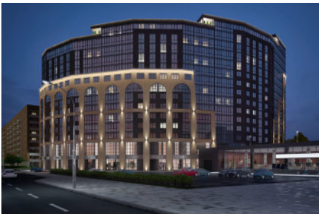
г. Ижевск, ЖК «Коллизей» Теплосчетчики с цифровым выходом 298 шт Счетчики воды с цифровым выходом 1093 шт
