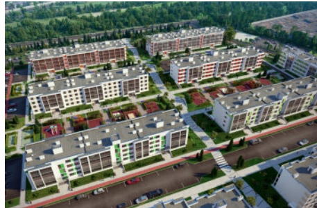
г. Тюмень, ЖК «Апрель» Счетчики воды с цифровым выходом 696 шт Теплосчетчики с цифровым выходом 256 шт
