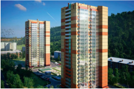
г. Красноярск, ЖК «Уютный дом на Калинина» Счетчики воды 600 шт
