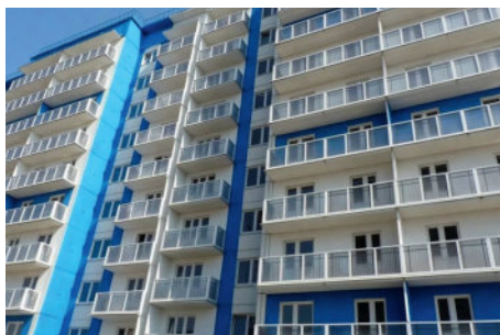
г. Липецк, ЖК «Лебедяжское» Распределители тепла 978 шт
