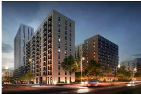
г. Москва, ЖК «Лефортово Парк» Коллекторные узлы отопления 112 шт
