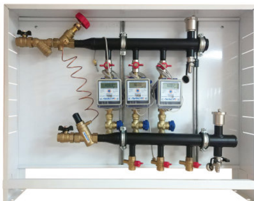
Узел коллекторный этажный
